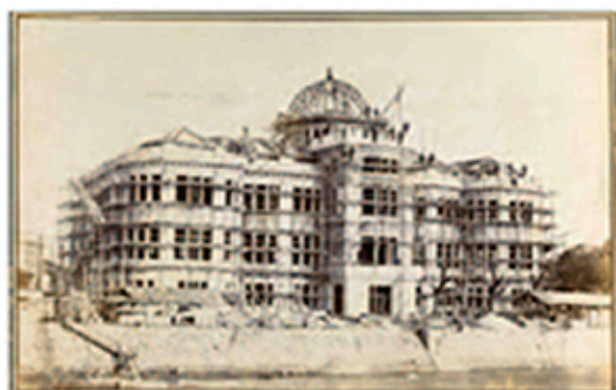
建築工事中の広島県物産陳列館。(広島市公文書館蔵)
