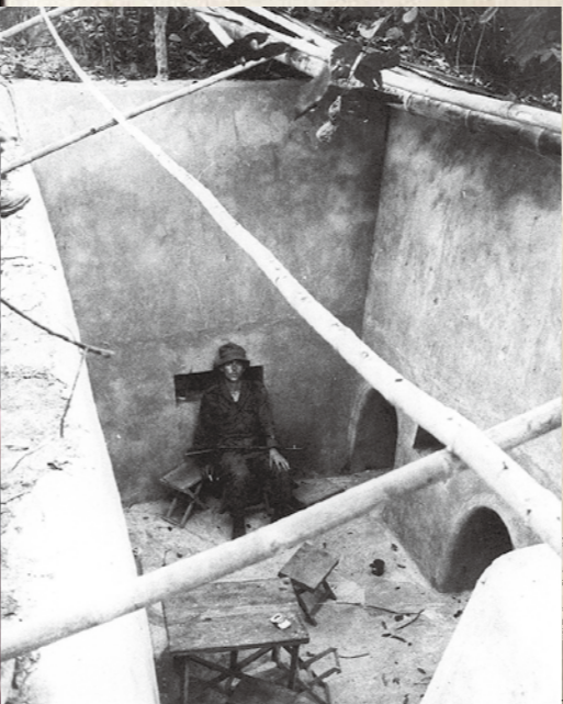
(上) オペレーションクリンプで発見されたトンネルで休憩するオーストラリア軍兵士。トンネルの一部は壁面がコンクリートで作られ、地面には鉄材が渡されていた。(右) 同じくオペレーションクリンプで発見されたトンネルを描いたイラストだが、ここでは丸太が機重にも組み合されている。この作戦で発見されたトンネルは場所により構造や建築資材に大きな幅があったが、どこであっても砲撃を想定して頭上の防御に最大限の努力が払われていた。
