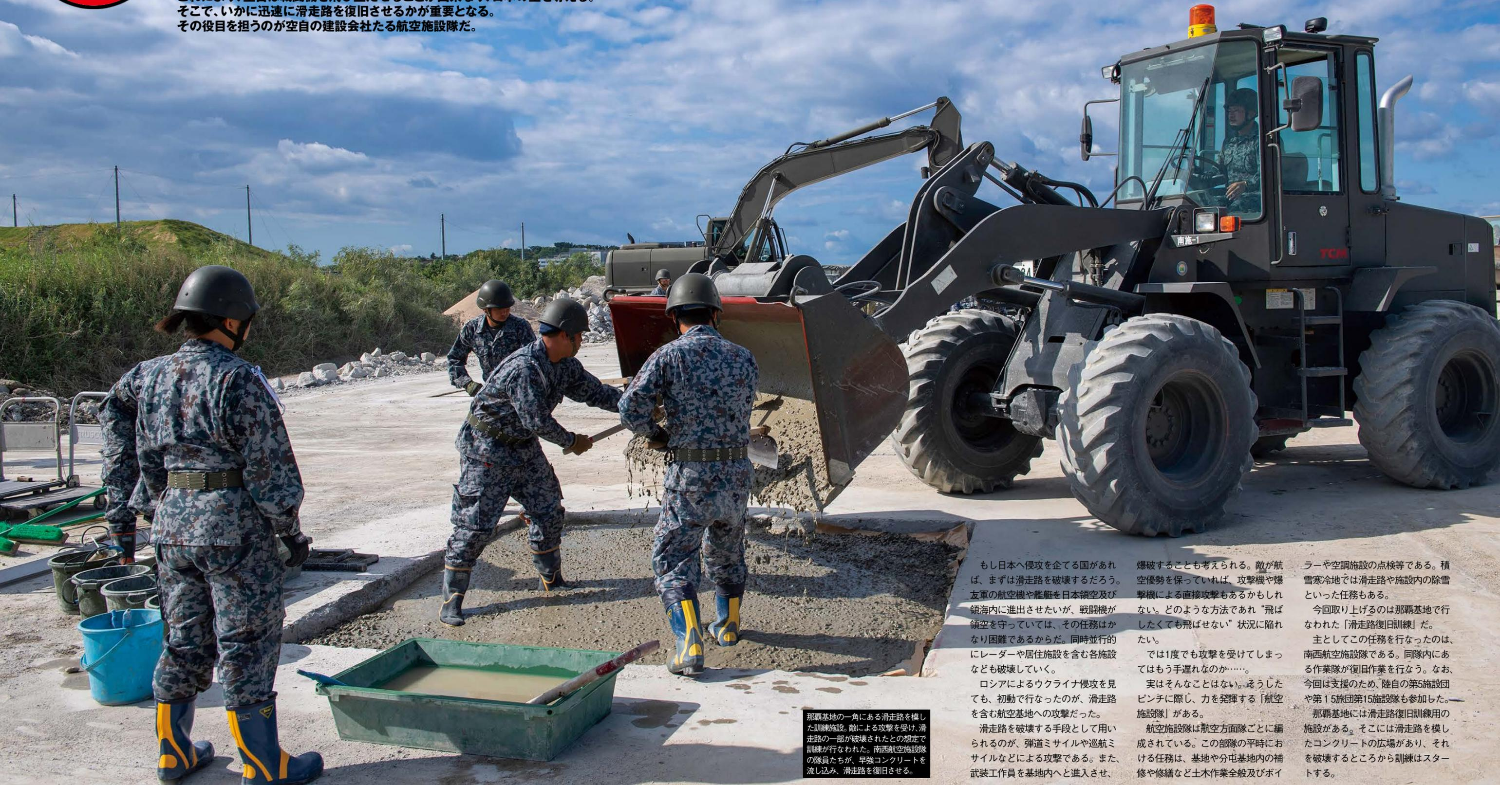
那覇基地の一角にある滑走路を模した訓練施設。敵による攻撃を受け、滑走路の一部が破壊されたとの想定で訓練が行なわれた。南西航空施設隊の隊員たちが、早強コンクリートを流し込み、滑走路を復旧させる。
